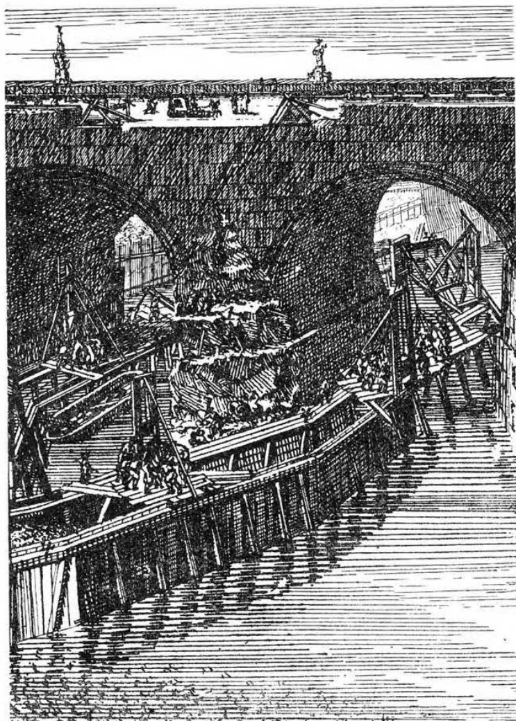
JÍMKA PŘI OPRAVĚ PILÍŘE KARLOVA MOSTU Z R. 1784.
